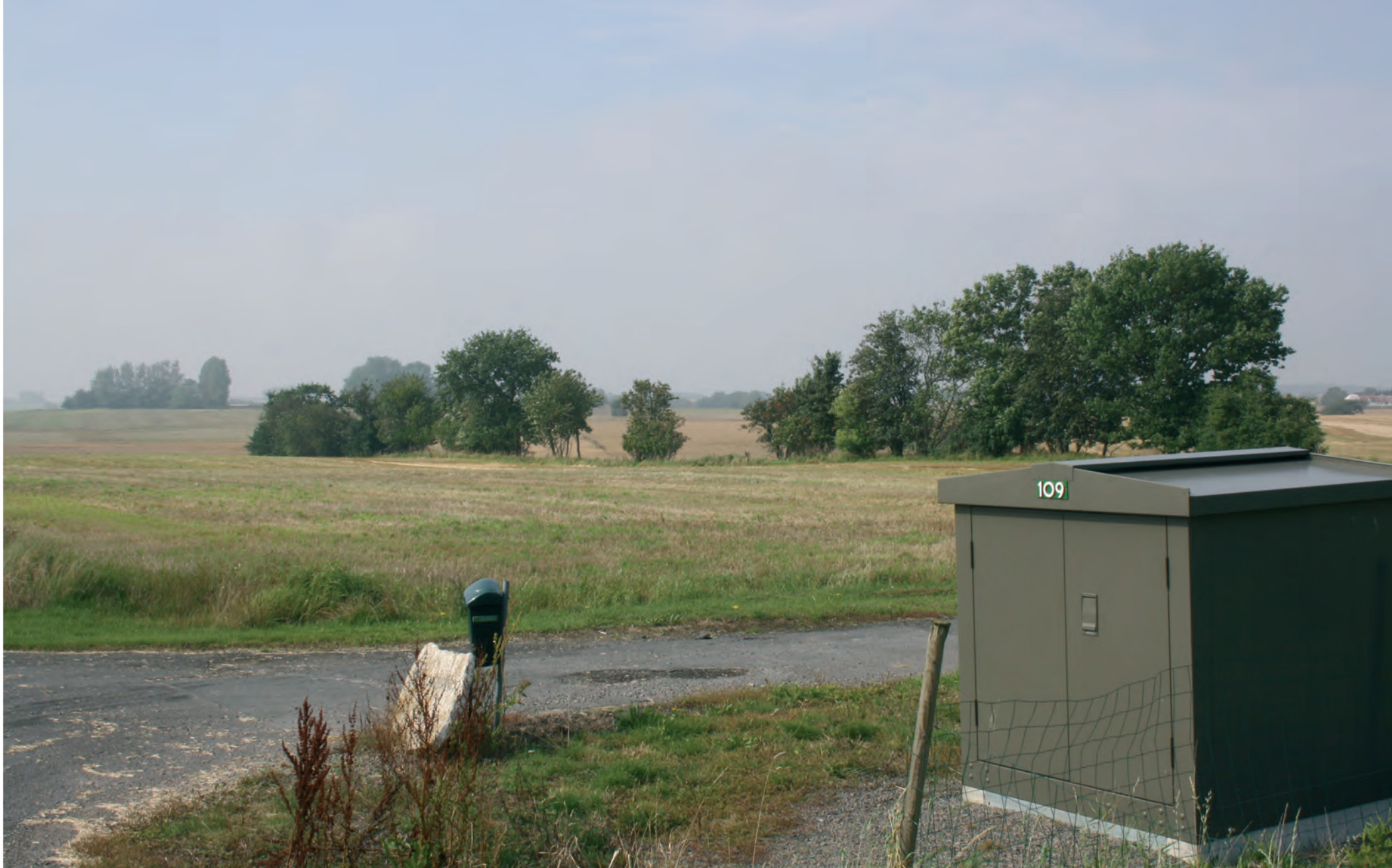
4b Eksisterende forhold. Foto mod vestsydvest fra Krashavevej tæt på transformerstation. Mellem de dyrkede marker står levende hegn med varierende tæthed. Der er delvis udsyn til vindmølleområdet.
